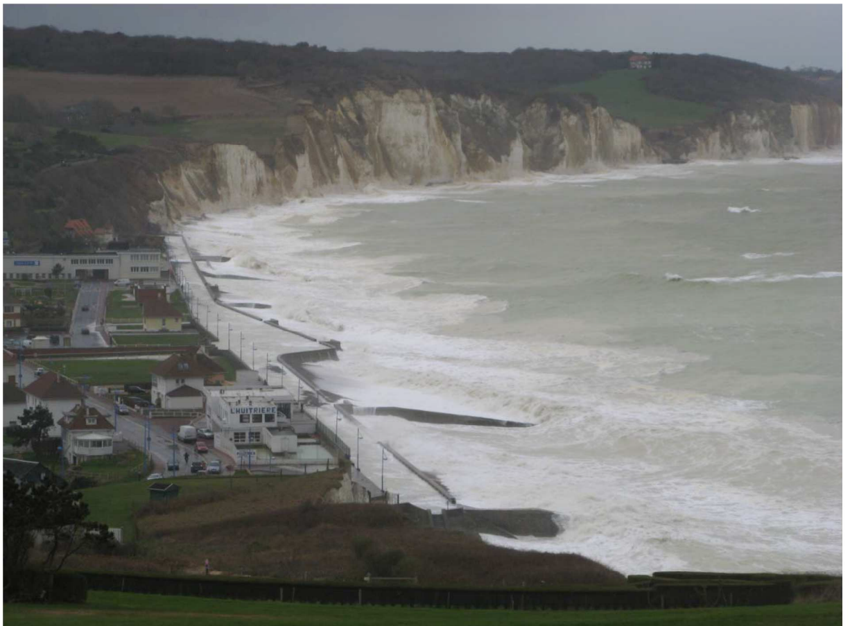
Franchissements observés le 31 mars 2010 à Pourville (commune d'Hautot-sur-Mer)(DDTM76)
