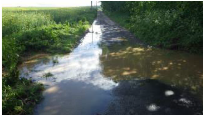
Photographie 5 : Inondation par traversée d'écoulement d'un talweg situé perpendiculairement à une voirie
