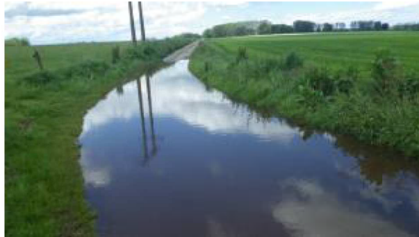
Photographie 4 : Inondation par stagnation d'eau dans une voirie
