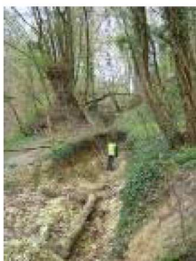
Photographie 3 : Chemin en cavée raviné par du ruissellement torrentiel
